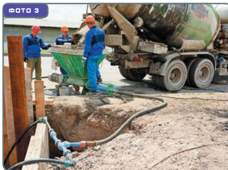
ТАМПОНИРОВАНИЕ МЕЖТРУБНОГО ПРОСТРАНСТВА
