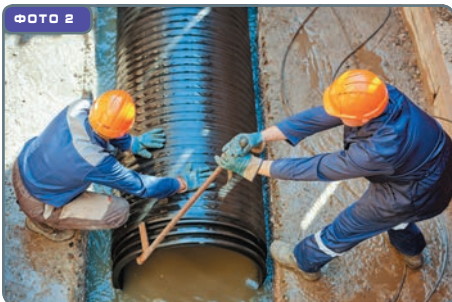
СВИНЧИВАНИЕ РЕЗБОВЫХ МОДУЛЕЙ
